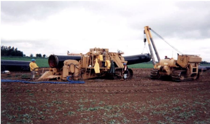
Figure n° 7 : Opération de cintrage des tubes (©MEDIATHEQUE GDF Suez)
