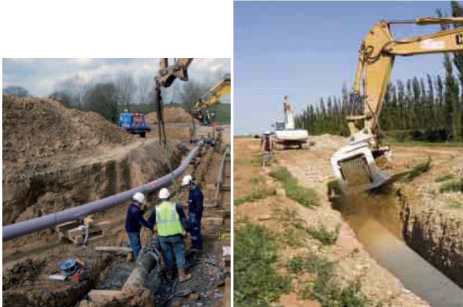
Figure n° 8 : Pose et remblai de la tranchée
