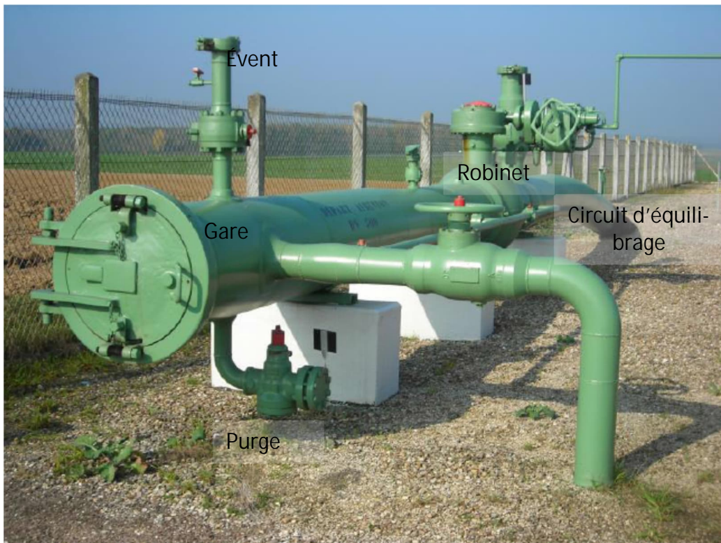
Figure n° 11 : Poste de demi-coupure
