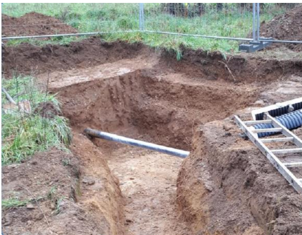
Figure 15 : Exemple de niche de raccordement
